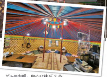
ゲルの内部。中心に柱が2本、天井には放射状に多数の梁（はり）、ラタンで格子状に組んだものを繋ぎ合わせて壁を作る。
